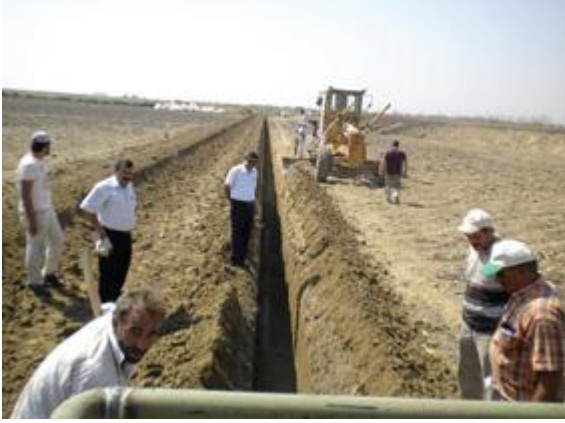
Kapalı drenaj sisteminin kurulması
