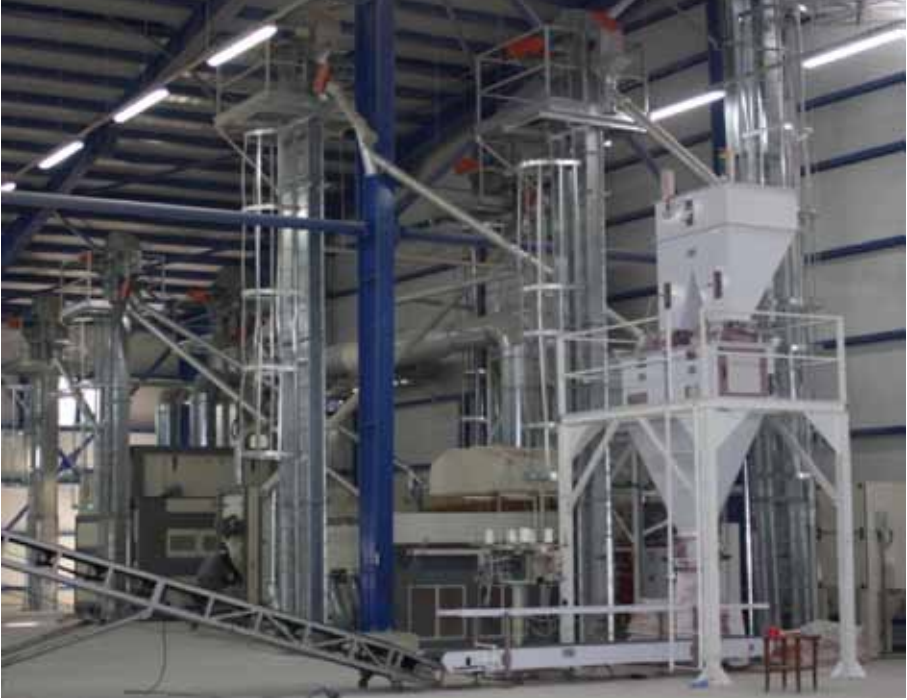
Tohumluk eleme tesisinin genel görünüşü
